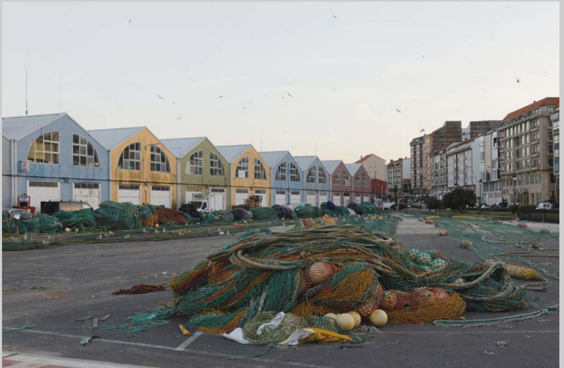
Límites ambiguos entre las zonas urbanas y portuarias y mal estado de las instalaciones e inmuebles del puerto, 2016.
