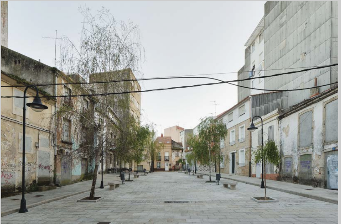
Estado actual de degradación de una de las plazas céntricas de Ribeira, 2016.
